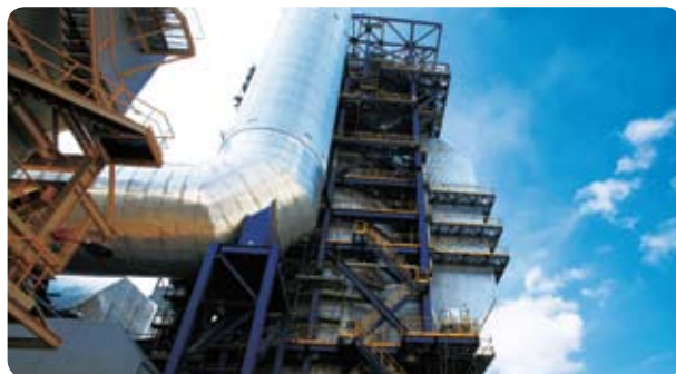
為五號燃煤機組加裝煙氣脫硫及低氮氧化物燃燒系統。
