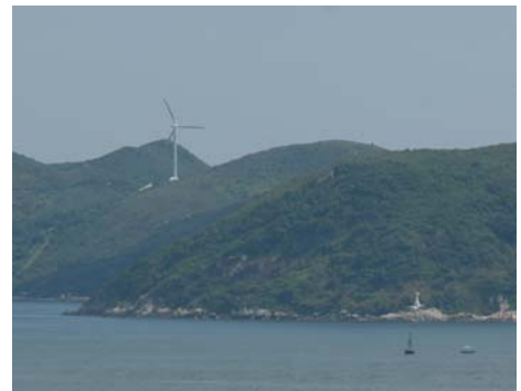
南丫島上的「南丫風采發電站」為全港首個具商業規模的風力發電站
