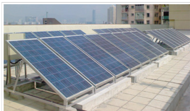
這套安裝在學校天台的太陽能光伏板裝置是環保基金資助的小型工程項目的例子。
