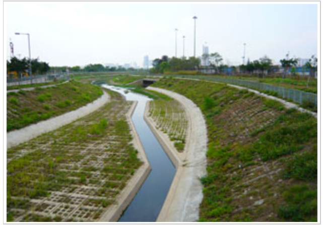
在新田東排水幹渠兩旁及底部鋪設混凝土草格。
