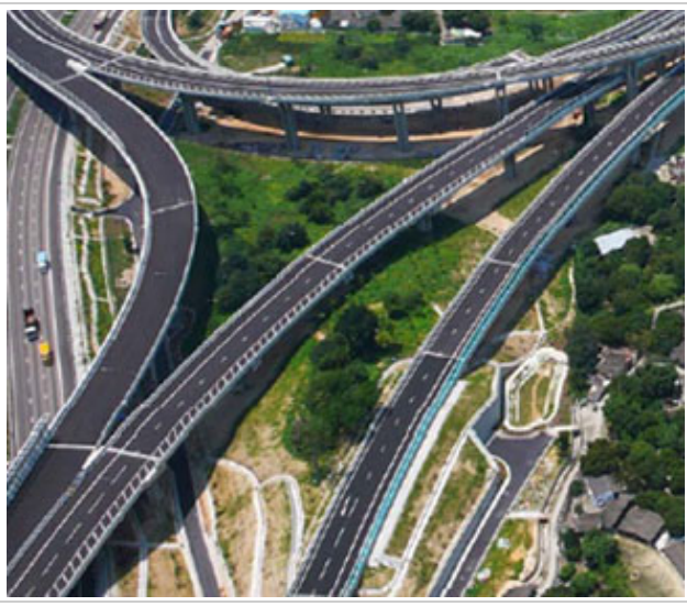
在高速公路鋪設低噪音路面。
