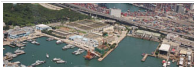
前期消毒設施將有助提升昂船洲污水處理廠的污水處理能力。
