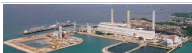
實施新的收緊排放管制後，南丫發電廠首先獲得續牌。
