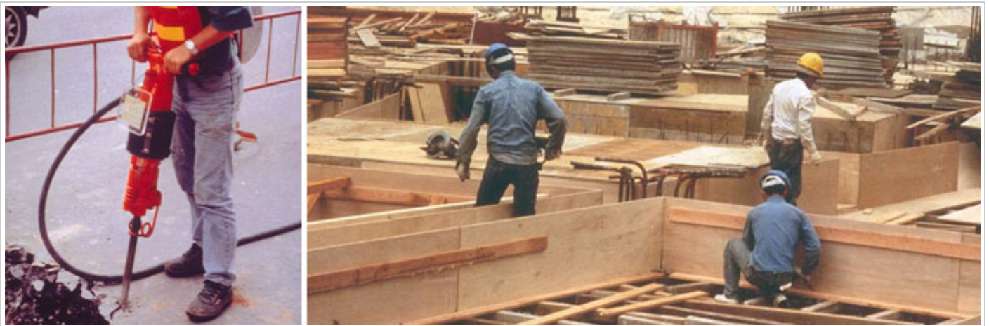
機動設備及人手操作活動所產生的建築工程噪音，在「指定範圍」內受更大程度的管制。
