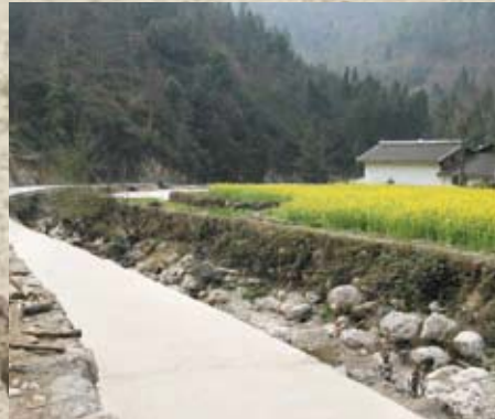
512地震震毀了四川青川縣一條村落中唯一通往城鄉的路，宣明會隨即協助村民建設新路，供手推車和摩托車往來行走，再也不怕路塌。
