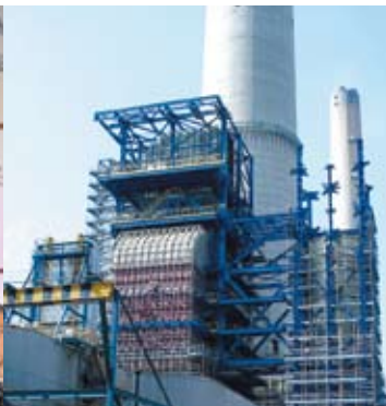
三台南丫發電廠機組正加裝煙氣脫硫裝置。
